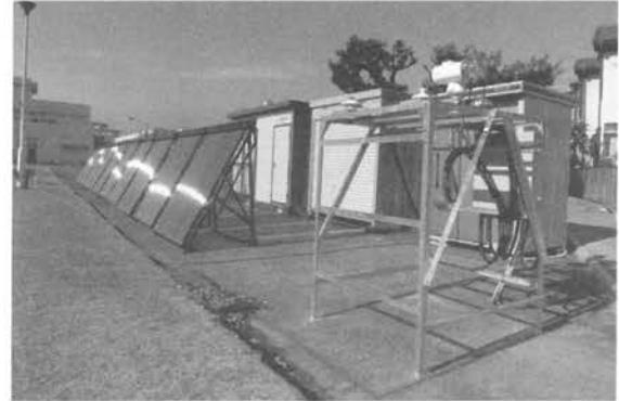
図 3.5.2 太陽熱温水システム
