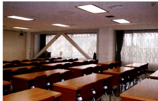
鉄骨ブレース
